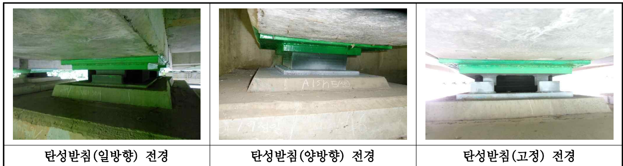
【사진 1.3.12】 교량받침 전경
