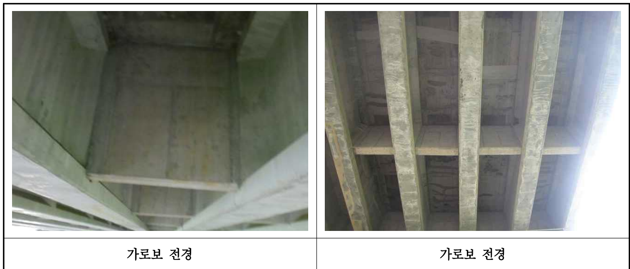
【사진 1.3.6】 가로보 전경
