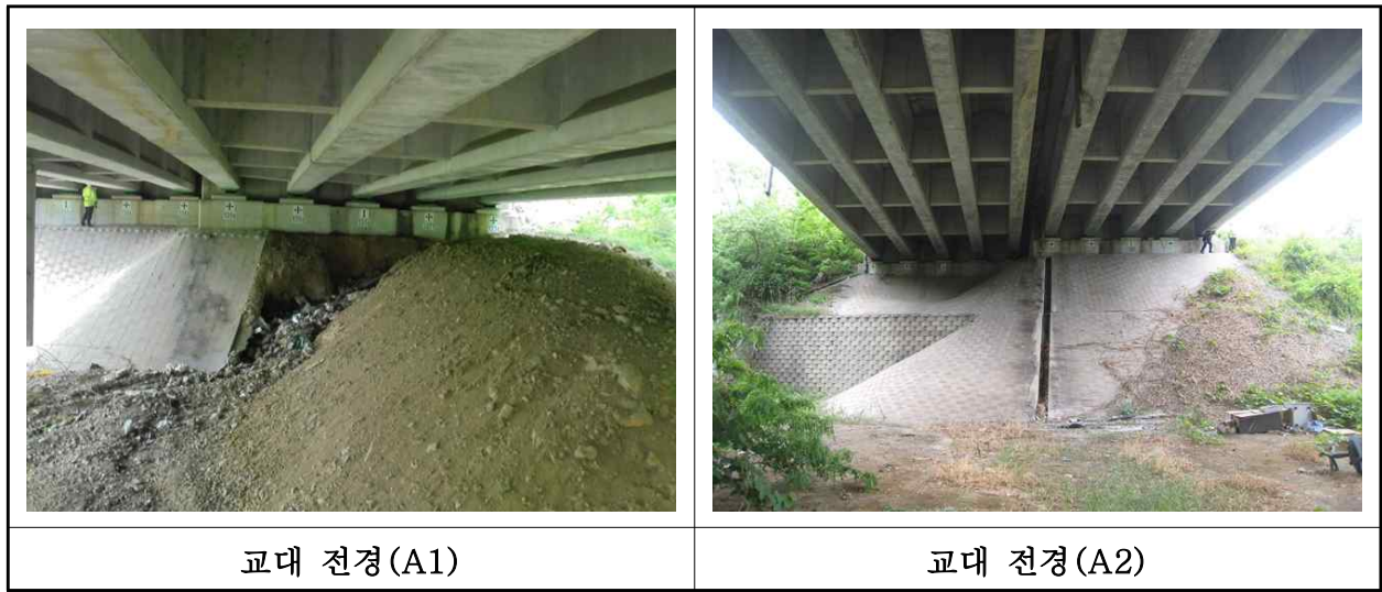
【사진 1.3.8】 교대 전경
