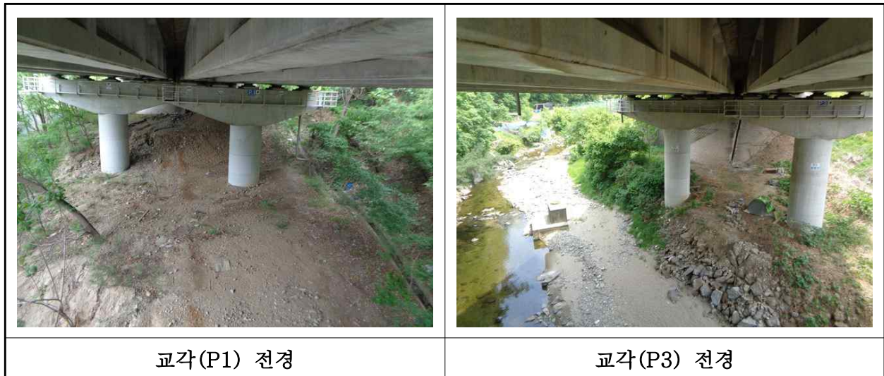
【사진 1.3.10】 교각 전경
