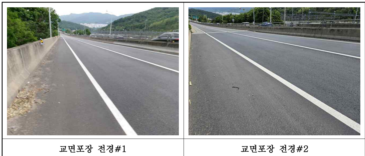
【사진 1.3.19】 교면포장 전경
