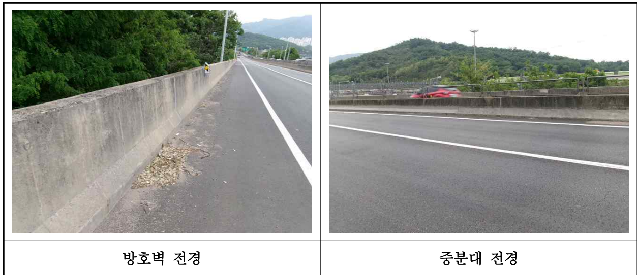
【사진 1.3.23】 방호벽 및 중앙분리대 전경
