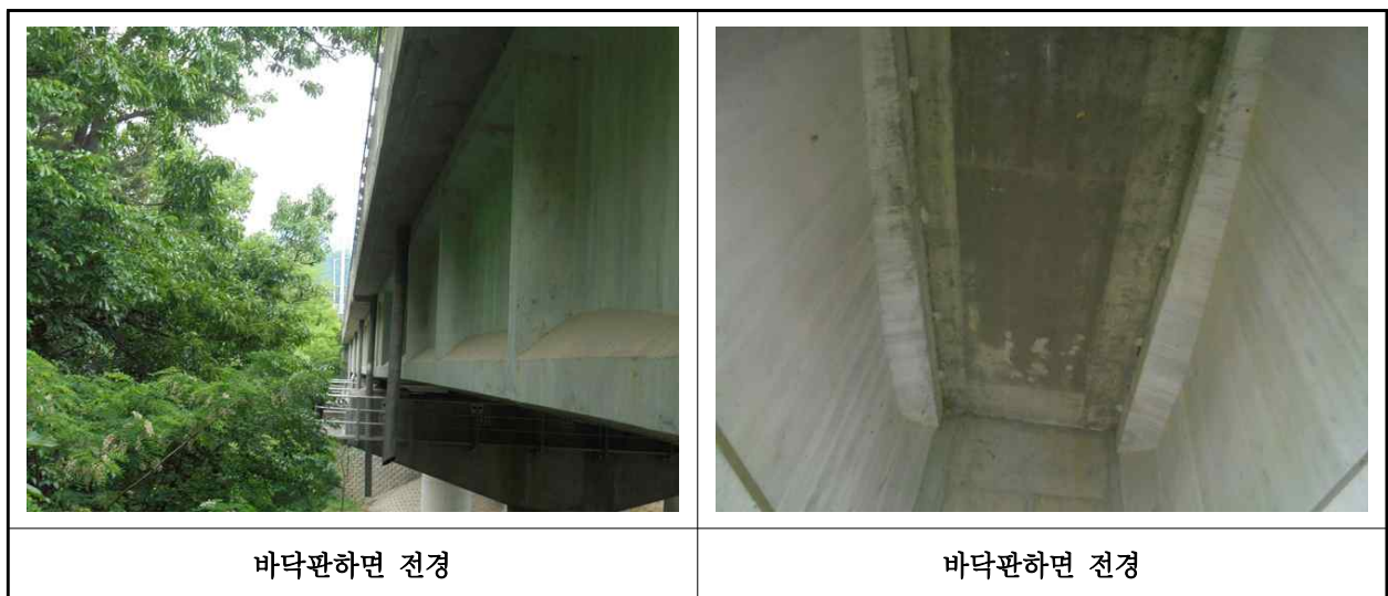
【사진 1.3.2】 바닥판하면 전경
