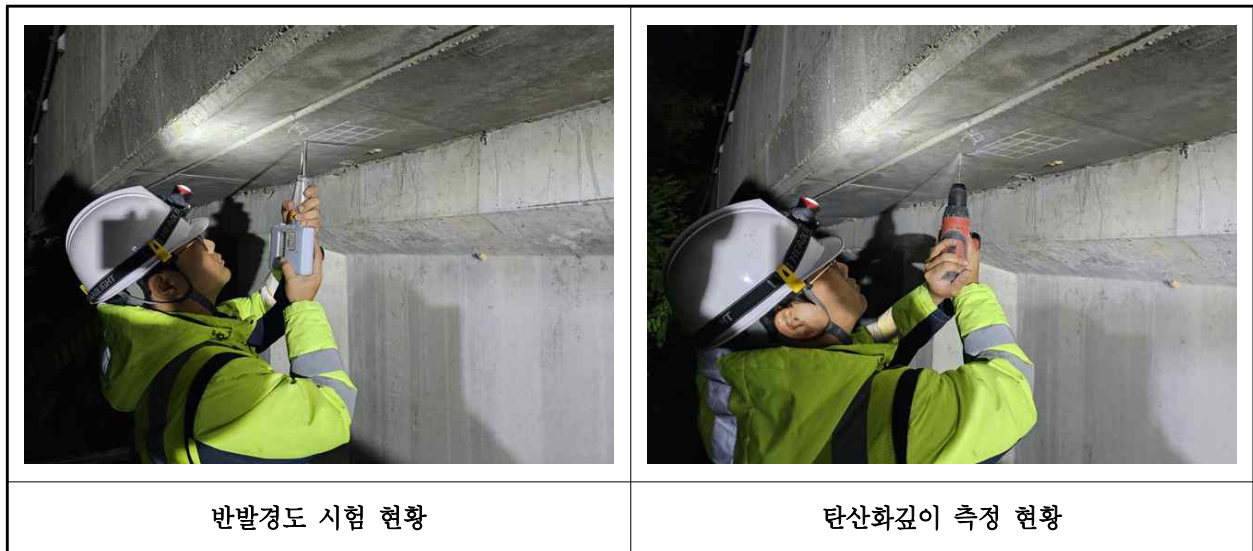
【사진 1.4.1】 콘크리트 내구성조사 현황
