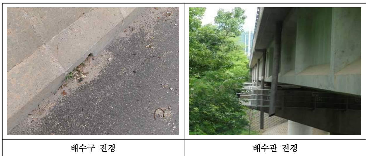
【사진 1.3.21】 배수시설 전경
