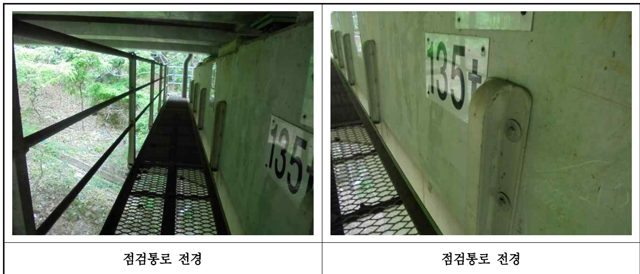
【사진 1.3.25】 교량 점검시설 전경
